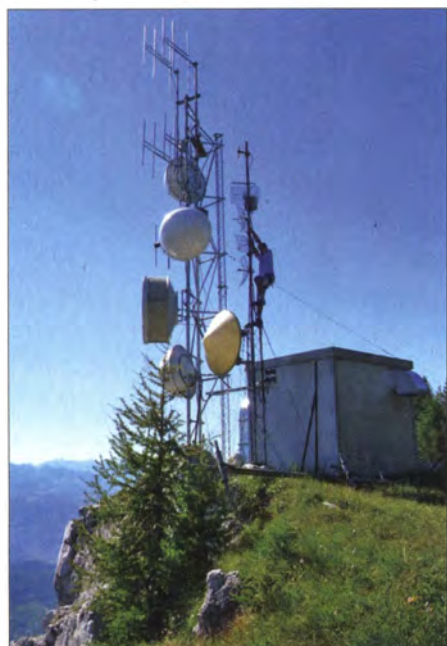
Bild 6: Sendeanlagen am Gantkofel (1866 m) bei Bozen; neben dem Rittner Horn (2260 m) ist dies ein zentraler Knotenpunkt für HAMNET und Allstar-Link in Südtirol.
