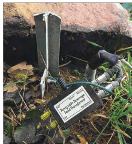
Bild 3: Staberder und Anschlussbox am Beginn der Zweidraht-BOG
