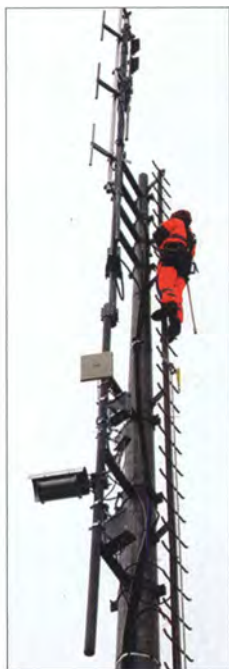
Bild 5: Sendemast am Piz Chavalatsch (2763 m); HD-Foto-Webcam, Datenfunk- und Sprechfunkrelais für 2 m sowie 70 cm finden dort Platz.
