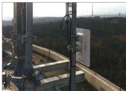
HAMNET-Linkantenne (MIMO-Panel) bei DB0VR in 750 m ü. NN Foto: DL1YBL
